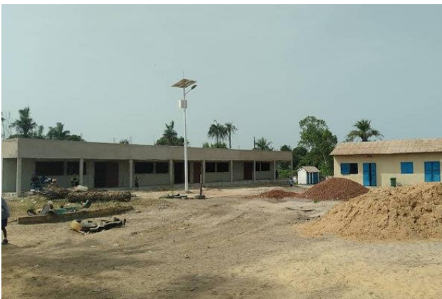
Links het nieuwe schoolgebouw met 4 leslokalen
